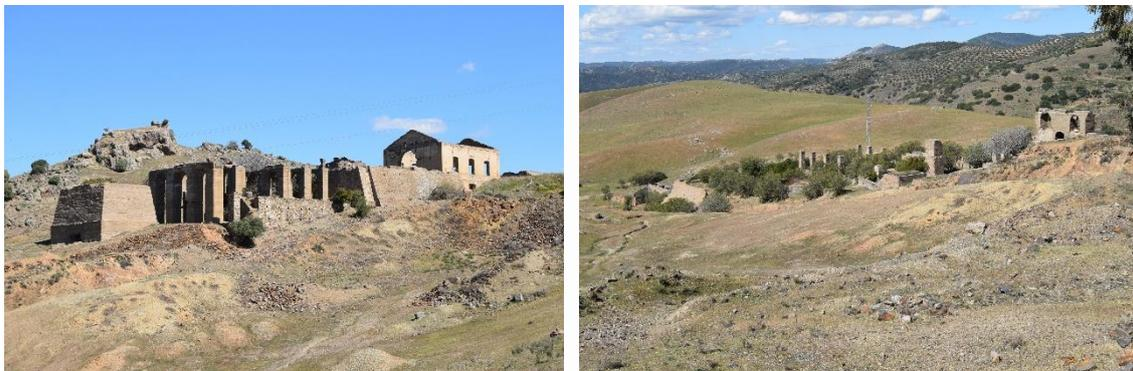
Figura 7. Detalle de algunas de las instalaciones en el poblado minero de la Rosa: la tolva de alimentación del pozo San Juan y construcción en arcos junto al mismo, seguramente destinadas a albergar las tolvas.
